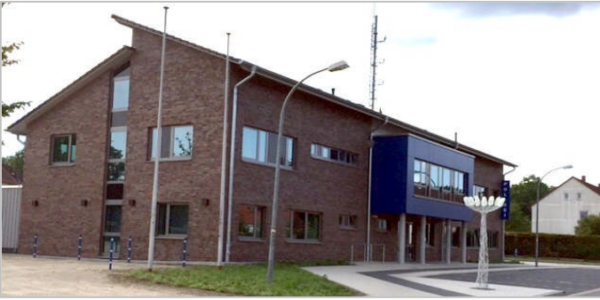
Baumaßnahme: Neubau eines Polizeikommissariats in Münster
