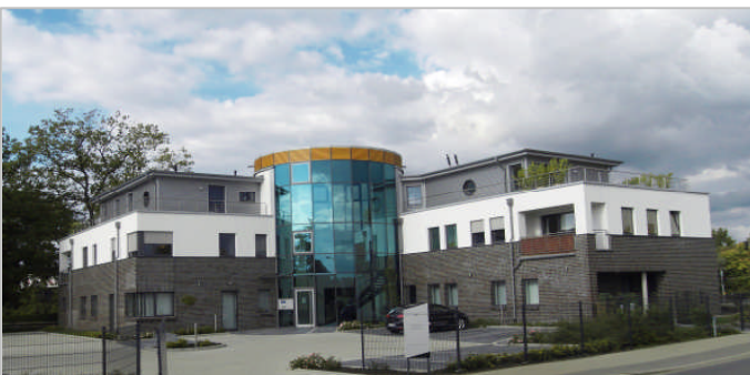
Baumaßnahme: Neubau eines Wohn- und Geschäftshauses in Münster
