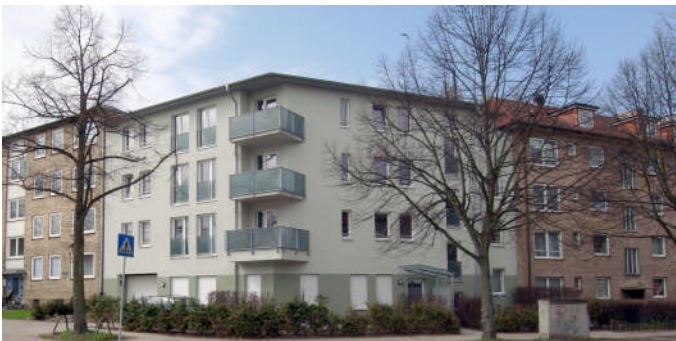
Baumaßnahme: Neubau Eines Wohnhauses mit 10 WE in Hamburg
