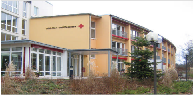
Baumaßnahme: Erweiterungsbau DRK Alten- und Pflegeheim in Münster
